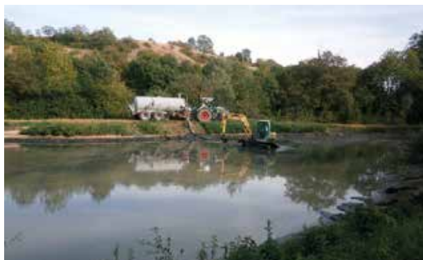
Curage des boues d'une station de type lagune (Souyri - 2016)
