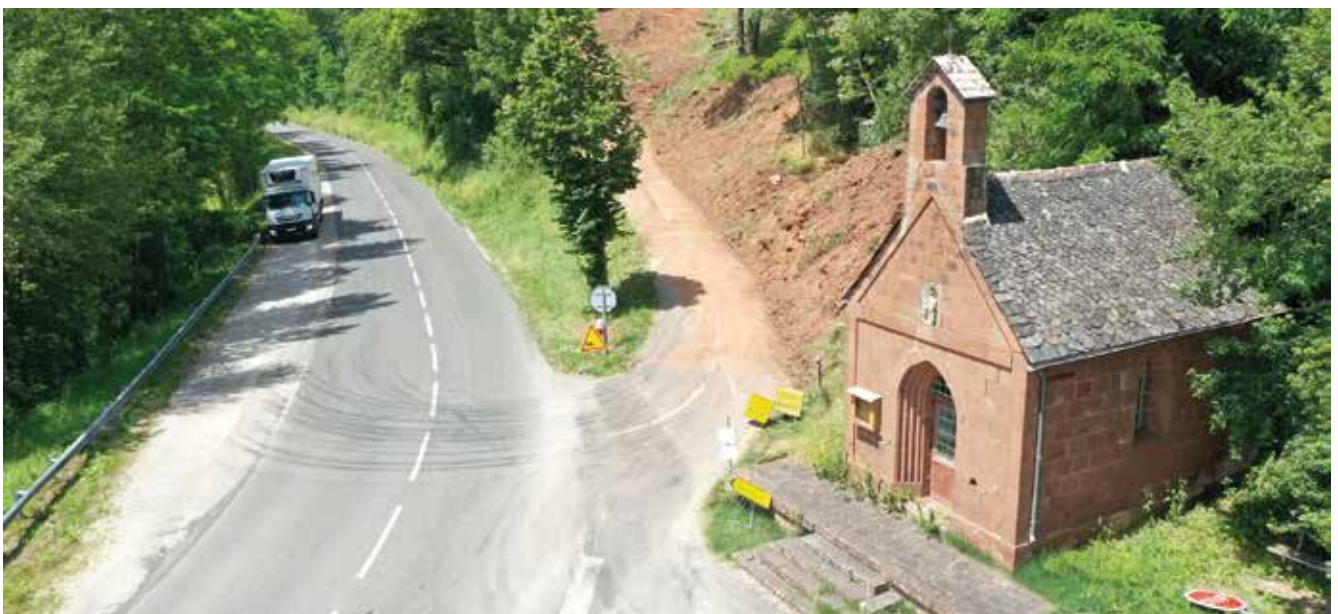
Terrassements réalisés dans le cadre de l'élargissement de la voie d'intérêt communautaire, à hauteur de Notre Dame de la Salette (Nauviale).
