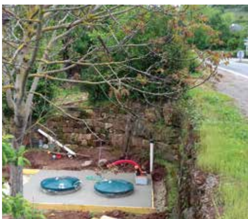
Le nouveau poste de relevage de Valady réalisé par l'entreprise Costes TPA
